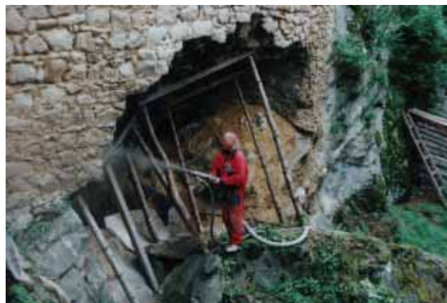
Torkretová skořepina na spojovací hradbě
